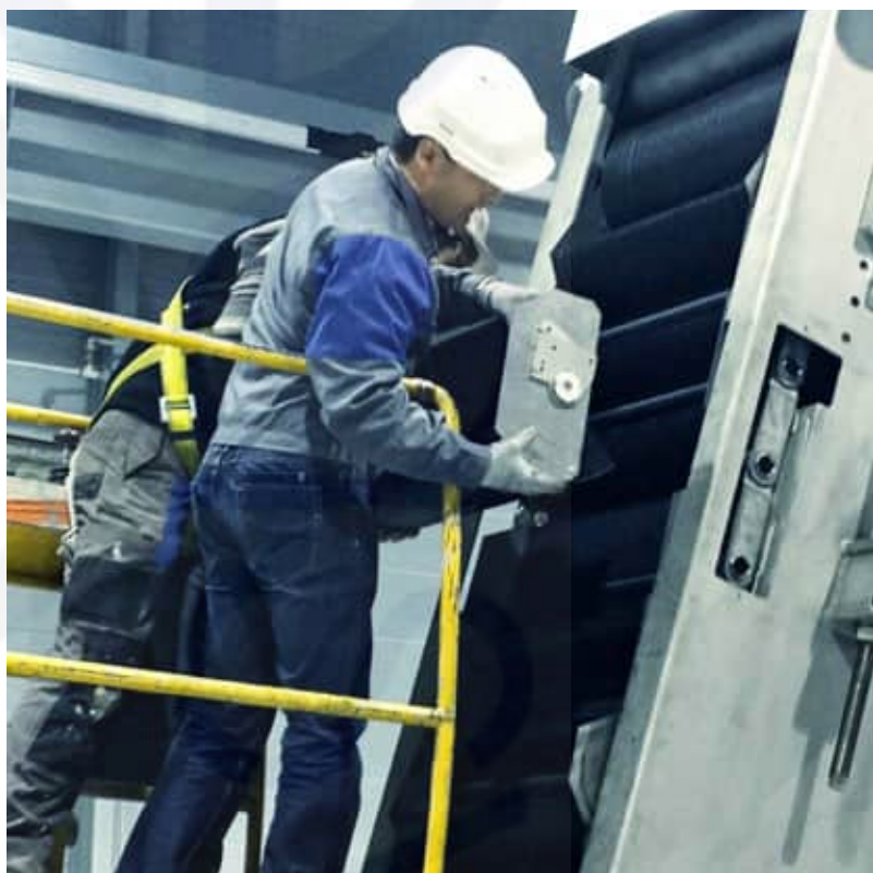
O elemento filtrante pode ser desmontado pela frente
